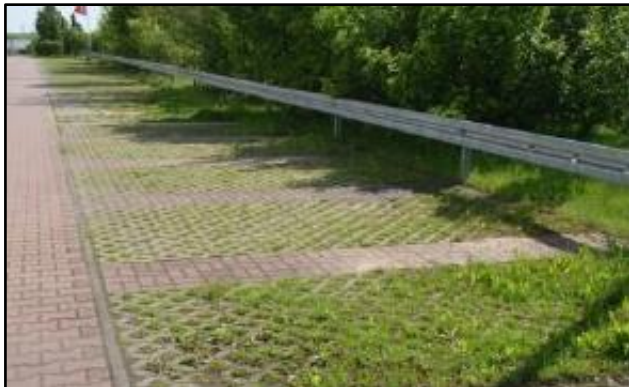
Figur 16. Exempel på genomsläpplig betongbeläggning med gräs.
