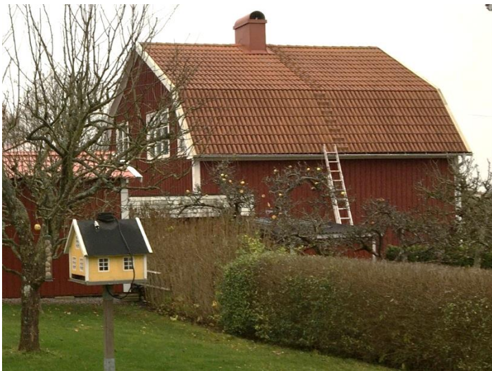
Bostadshuset fotograferat från Kalkstensvägen i norr.
