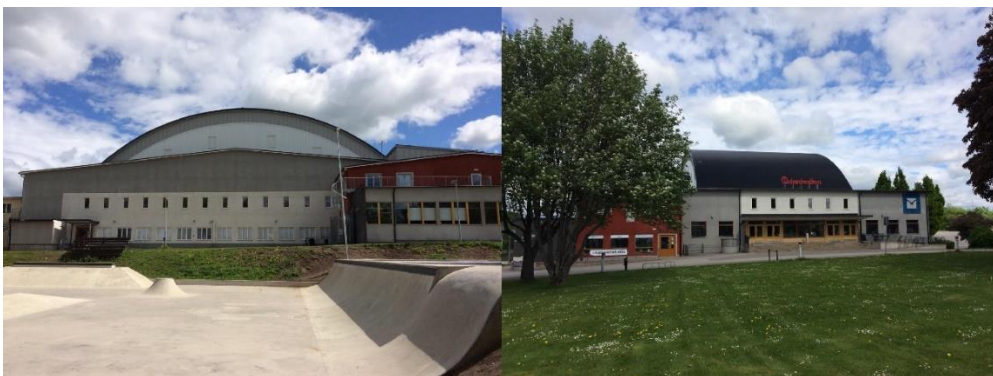
Figur 10. Figuren visar Odenhallen som är belägen strax norr om planområdet. Bilden till vänster är tagen västerifrån och bilden till höger är tagen söderifrån.
